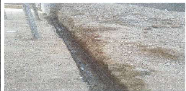
Foto 4: Área donde se construyó el muro de concreto
