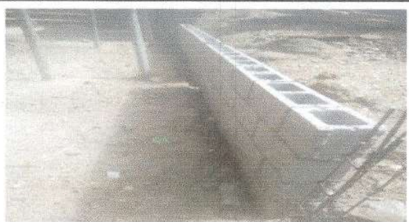
Foto 5: Área donde se realizó la reparación del muro de block
