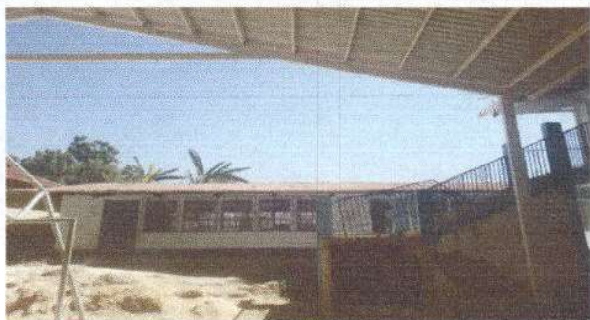
Foto 1: Área donde se realizó el cambio de techo
