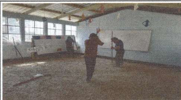
Foto 2: Área donde se cambió el piso a cerámico
